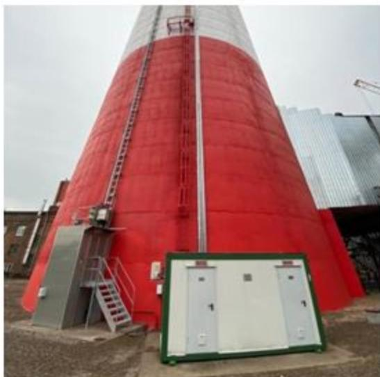
Рисунок 5.7. Пример исполнения блока-контейнера.
