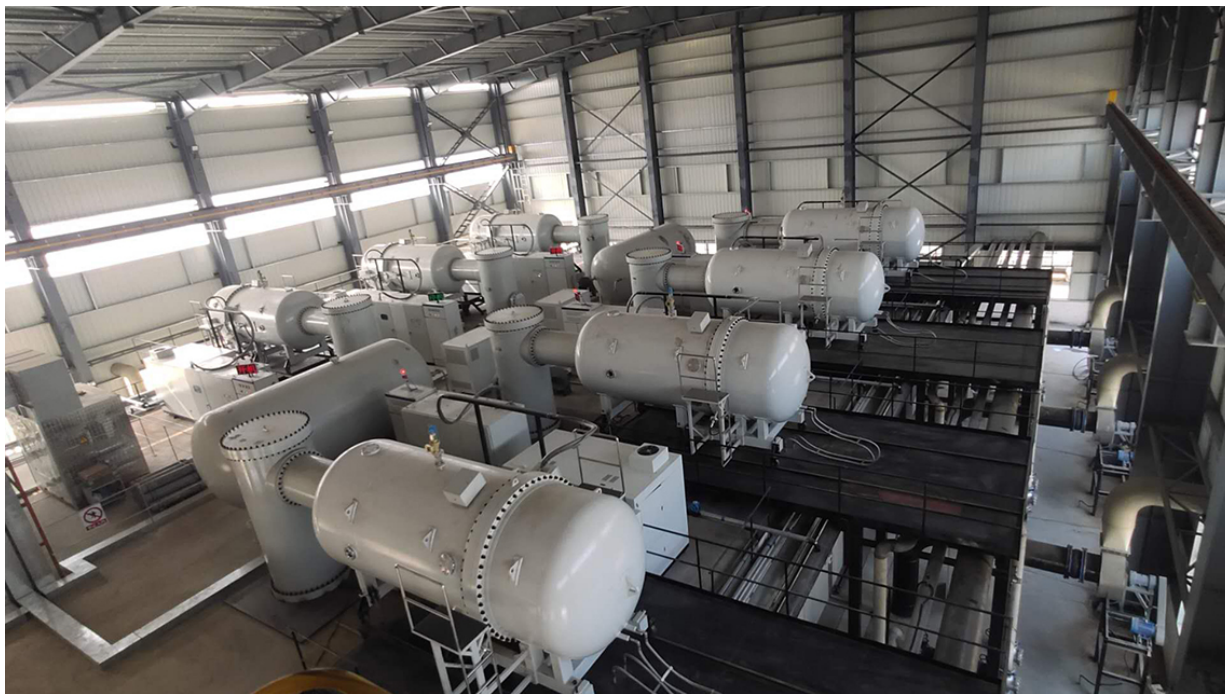
Рисунок 7.2. Обработка семью ускорителями электронов образовавшихся после печатания и окрашивания тканей сточных вод на трикотажной фабрике "Гуаньхуа"
