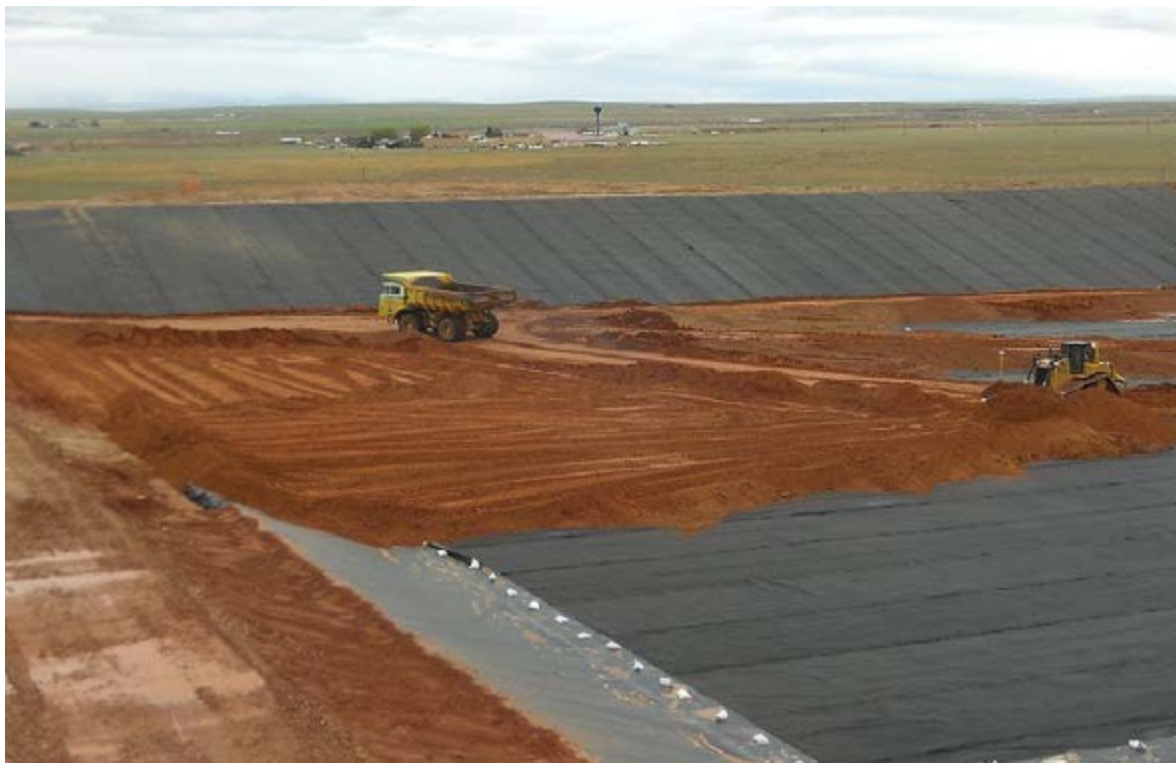
Рисунок 24- Строительство полигона для размещения отходов
